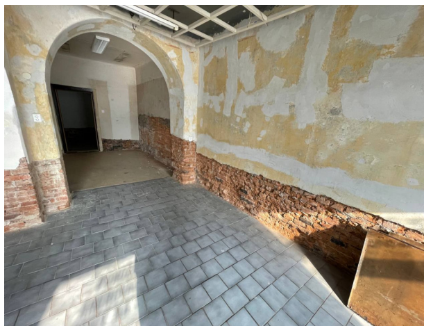
Obr. 1) Osekané omítky – obvodová stěna prodejny
