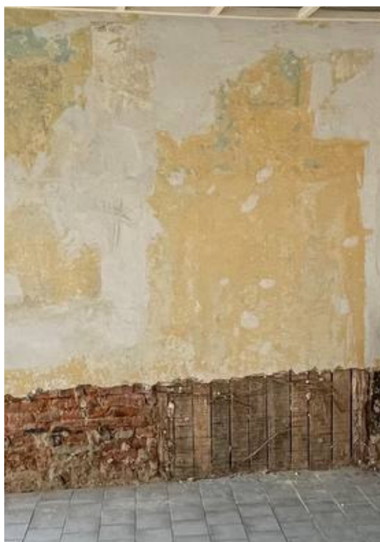
Obr. 7) Zabedněné dveře dřevěnými prkny – prodejna
