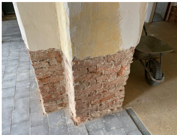
Obr. 3) Osekaná omítka – Vnitřní stěna prodejny
