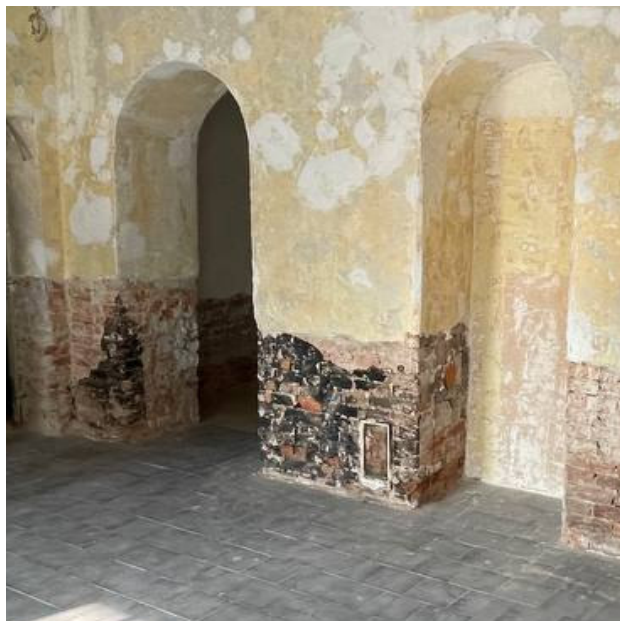
Obr. 5) Zbytky asfaltového nátěru – vnitřní stěna prodejny
