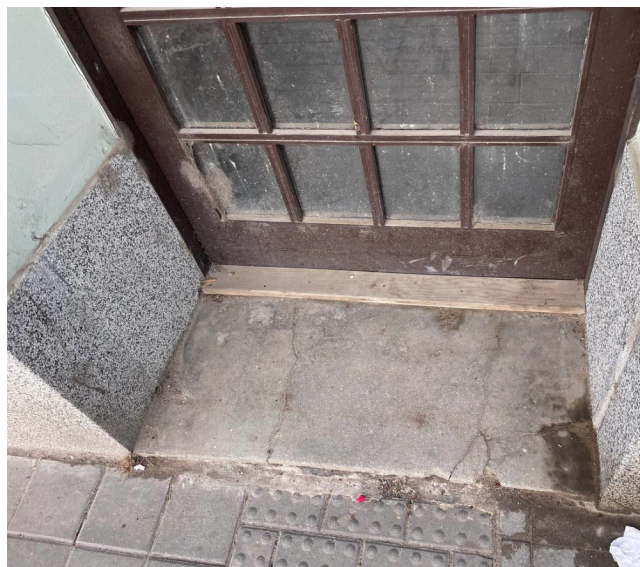
Obr. 4) Degradace betonové plochy u vchodu – uliční chodník u prodejny
